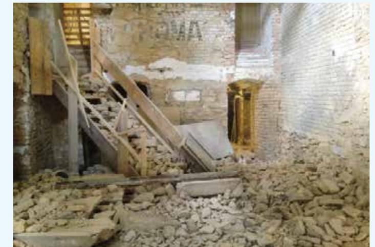
Zwischenzeitlich sah es in der Walkmühle während der Sanierungsarbeiten eher aus wie nach einem Bombenangriff. « Abbruch von Zwischendecken im Turm der Walkmühle. Foto: Künstlerverein Walkmühle
